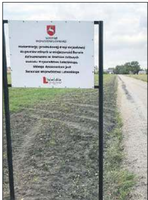
W Burwinie w gminie Łomazy trwają prace modernizacyjne na drodze dojazdowej do gruntów rolnych
