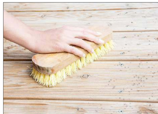
Przed olejowaniem dokładnie czyszcimy całą powierzchnię. Zanieczyszczenia powierzchniowe sprzątam za pomocą twardej szczotki z tworzywa
