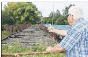
– W wyniku interwencji most został już częściowo rozebrany – mówi mieszkaniec Białej Podlaskiej (zdj. przed rozbiórką)
