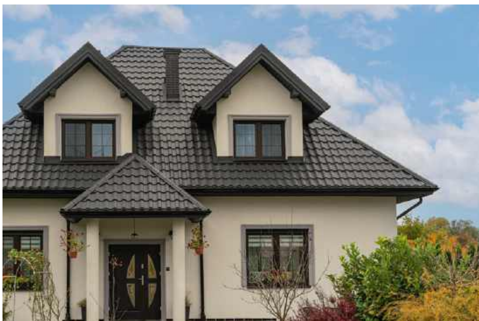
❶ Blachodachówki modułowe mają postać niewielkich paneli, dlatego dobrze się sprawdzają w przypadku bardziej złożonych konstrukcji dachowych. BLACHY PRUSZYŃSKI
