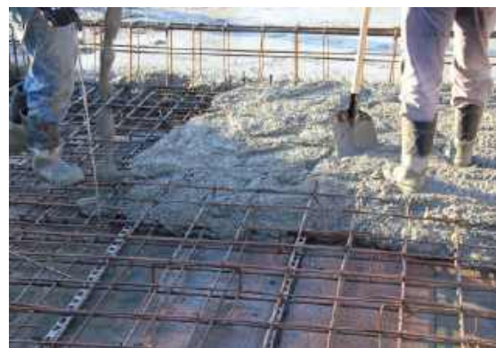
🔧 Strop monolityczny wymaga pełnego deskowania. J. WERNER
