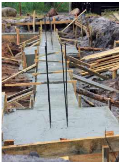
Ławy fundamentowe gotowe. J. WERNER
