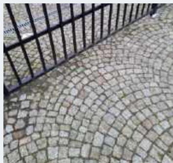
❷ Przy bramie wjazdowej, w kamiennej nawierzchni osadzono odpływ liniowy.
