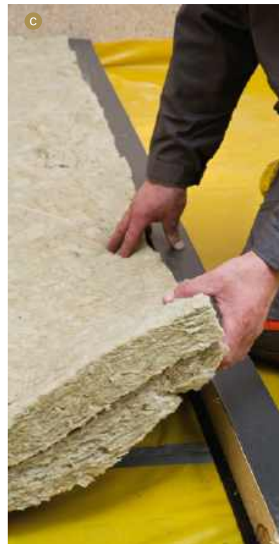
📌 Wełna mineralna ma powszechne zastosowanie w budownictwie. Wykorzystywana jest do izolowania ścian (a ISOVER), dachów (b ROCKWOOL), stropów (c WOODECO), a także przewodów wentylacyjnych i klimatyzacyjnych (d URSa).
