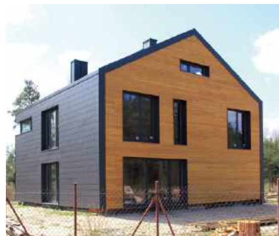
🔧 Dom w stanie surowym zamkniętym. J. WERNER
