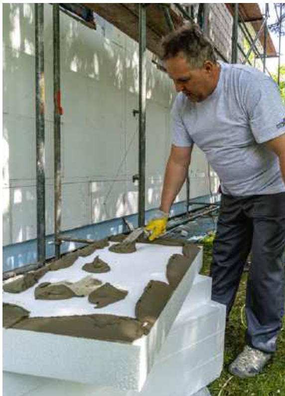
🔧 W najbardziej rozpowszechnionej metodzie lekkiej suchej styropian lub wełnę mocuje się na zaprawę klejową bezpośrednio do muru. AUSTROTHERM
