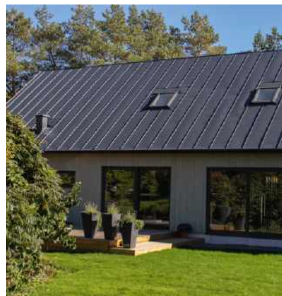
Rąbek stojący to najczęściej stosowany obecnie sposób łączenia blachy płaskiej.
