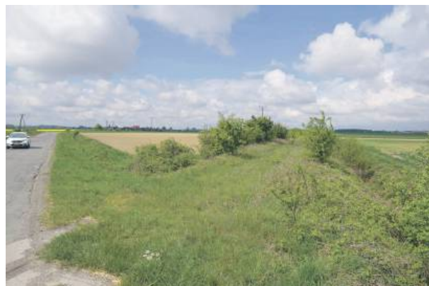
Odcinek trasy rowerowej Strzelin-Krzepice powstanie na nasypie nieczynnej linii kolejowej
