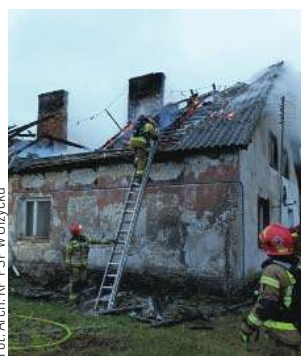
Dom w wyniku pożaru został zniszczony, nie nadaje się do zamieszkania
