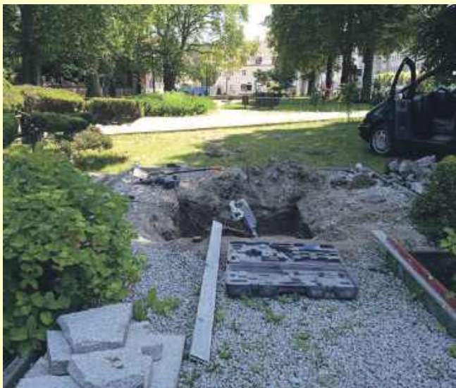
Pomimo upałów trwają prace przy fundamentach pomnika.
