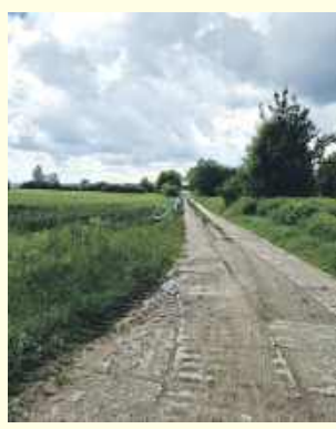
Na ul. Pierwoszwowskiej w Wiszni Małej wykonano 847 metrów sieci wodociągowej wraz z odtworzeniem terenu po zakończeniu prac
