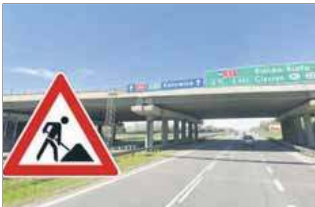
Remont wiaduktu ma potrwać do jesieni
