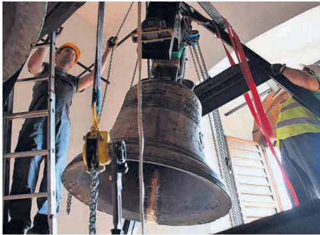
Operacja wciągania Maryana na wieżę farną trwała ponad 2,5 godziny. Po zamontowaniu sprawdzono, jak bije dzwon
