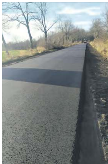
Nowa nawierzchnia drogi z Racławic
