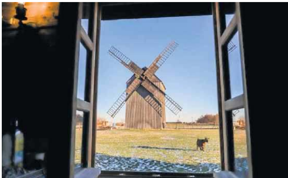
Paltrak obracany jest przez młynarza, nie potrzeba do tego żadnych maszyn, choć waży tonę
