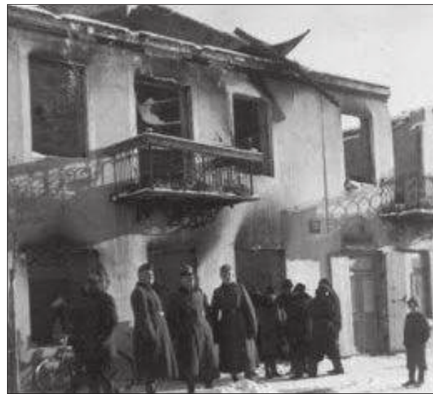
➤ Najwięcej zniszczeń odniosła zabudowa na ul. Poniatowskiego, czyli ówczesna ul. 11 Listopada (foto: Ryki Dawniej)
