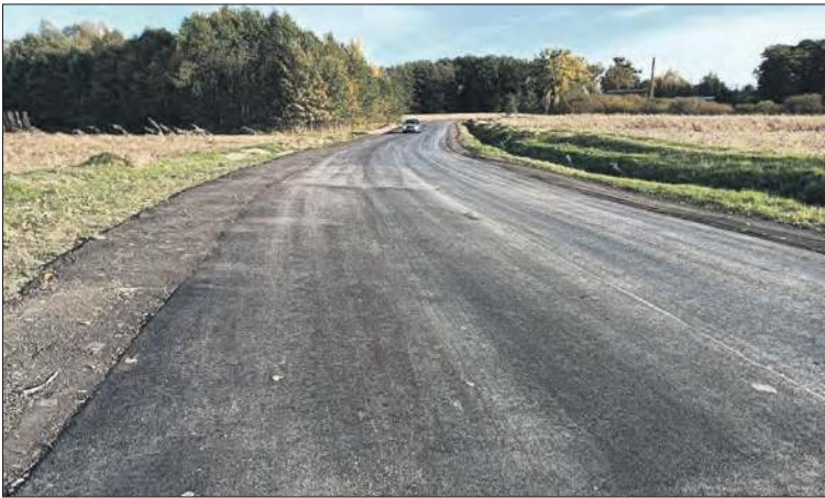
Naprawa drogi ma na razie charakter tymczasowy
