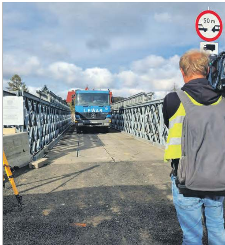
Próba obciążeniowa mostu
