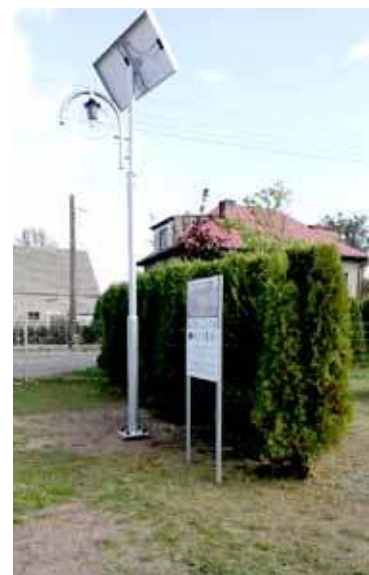
Dzięki dofinansowaniu na placu zabaw w Krzywnicy zamontowano lampy solarne
