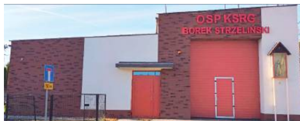
Remiza w Borku Strzeleńskim przeszedł termomodernizację. Fot. UG w Borowie
