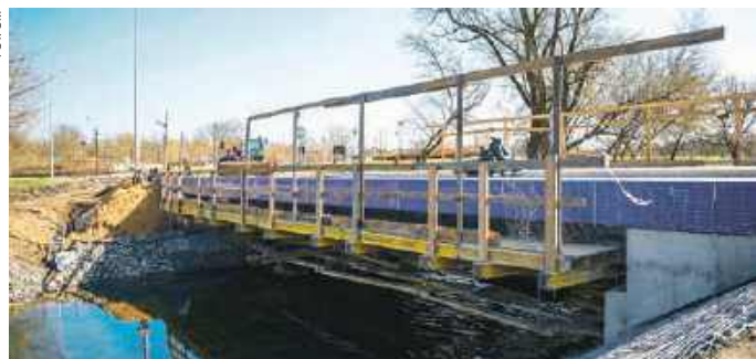
Remontowany most na ulicy Augustańskiej
