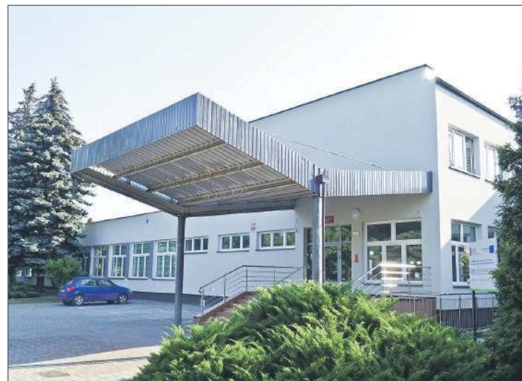
Budynek szkoły muzycznej zostanie ogrodzony.
