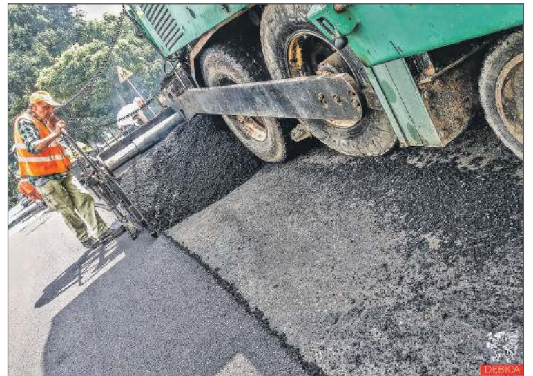
Na ul. Sportowej prace już się zakończyły.
