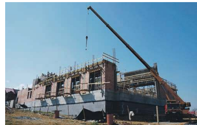
Koronawirus nie wstrzymał budowy libiąskiego basenu
