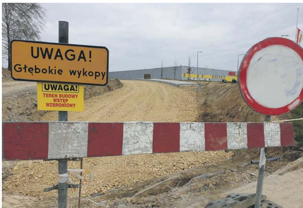
W sąsiedztwie marketu budowlanego w Krzeszowicach powstaje droga
