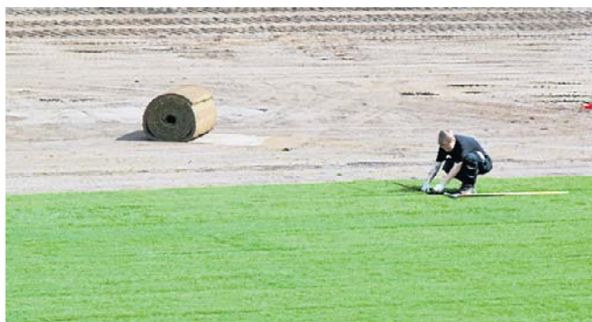
Modernizację przejdą obiekty w Kobylnicy i Człuchowie.
