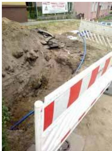
W zakresie zadania jest wymiana dziewięciu przyłączy wodociągowych do pobliskich budynków
