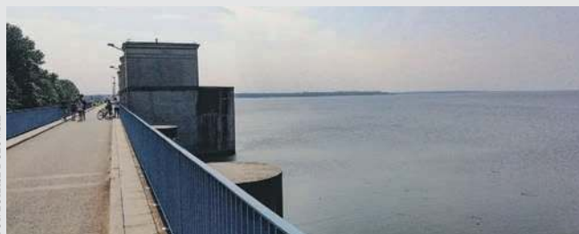
W 2005 r., w ramach modernizacji zapory na Jeziorze Goczałkowickim, utworzono na jej koronie ścieżkę spacerową
