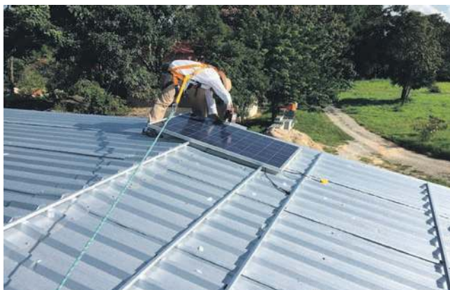
Montaż paneli na dachu domu
