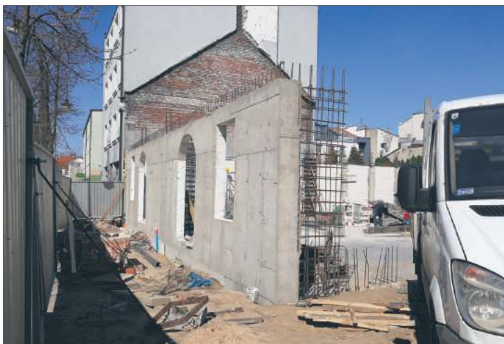
Przy ulicy Kościuszki 3b powstają mieszkania w programie „Mieszkanie na start” oraz siedziba Mediateki Książnicy Płockiej
