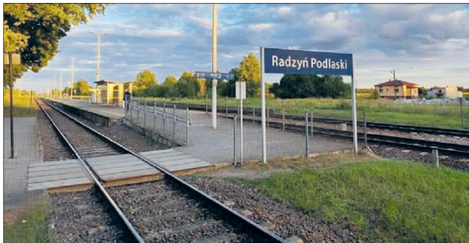
Dzisiaj prace na odcinku od krajowej dwójki do stacji PKP trwają. Pod koniec lipca wójt Daniel Grochowski informował o postępach
