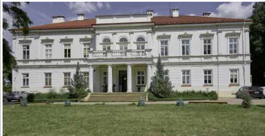
Budynek pałacowy w Stoku Lackim doczeka się nowej elewacji i prac konserwatorskich.
