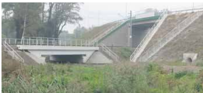
Wiadukt został w końcu ukończony
