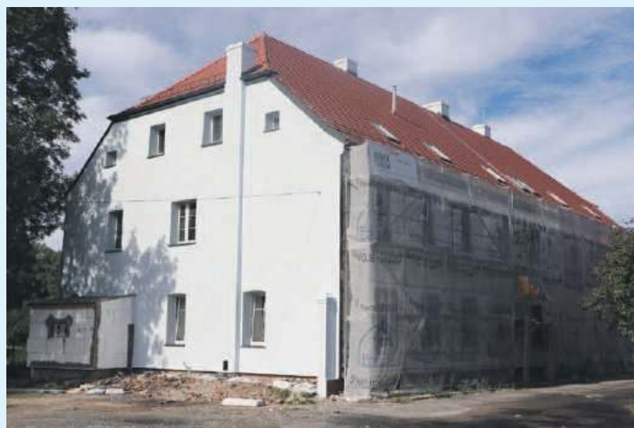
Remont budynku mieszkalnego przy ul. Kutrowskiego 4
