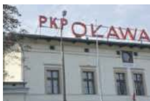
Na modernizację trzeba będzie poczekać
