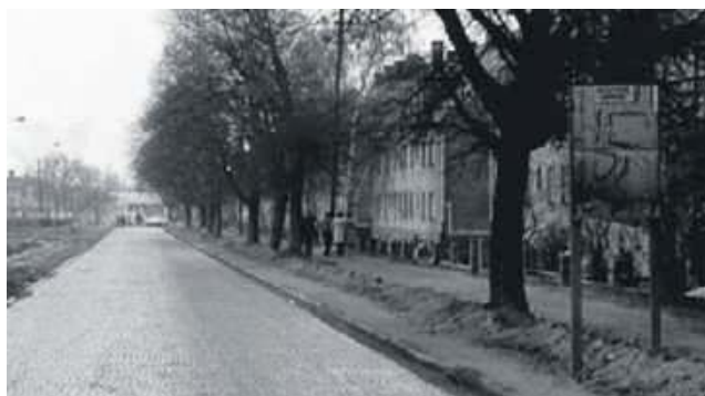
1971. Ulica Opolska. Po prawej lewy znak drogowy informujący o objeździe w prawo na ulicę Dąbrowskiego i Małodworców, w związku z budową wiaduktu
