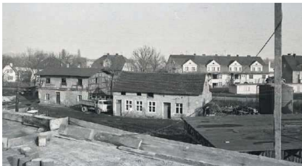
1973. Zdjęcie zrobiłem z wiaduktu w budowie, w kierunku ul. Różanej. Na pierwszym planie widzimy budynki, które wyburzono
