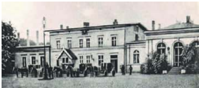
Tak wyglądał w latach świetności - modernizacja miała zbliżyć go do tego stanu
