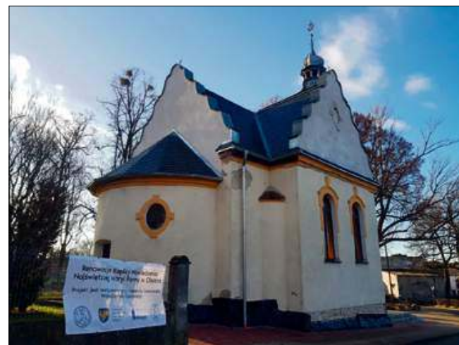
Kaplica w Oleszce wymaga dalszej renowacji.
