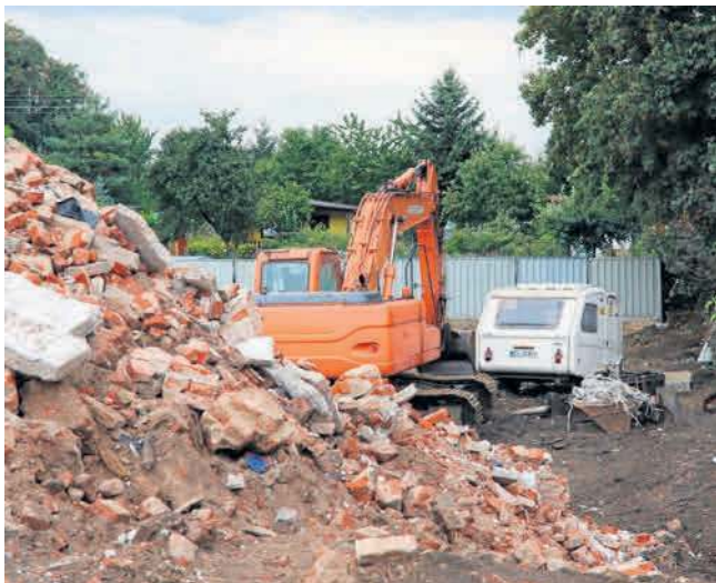
Przy Odolanowskiej w miejscu, gdzie będzie komora startowa maszyny drążącej tunel, trwa rozbiórka budynków
