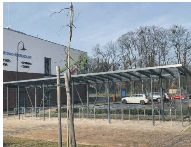
A tak wygląda nowa wiatka na rowery, która kosztowała ponad 50.000 zł. Czy gmina zażądała od wykonawcy pokrycia tych kosztów? W końcu zamontował wiatę niezgodną z projektem.
