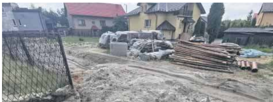
Wodociągi twierdzą, że prowadzone prace nie mają żadnego wpływu na istniejące przyłącza
