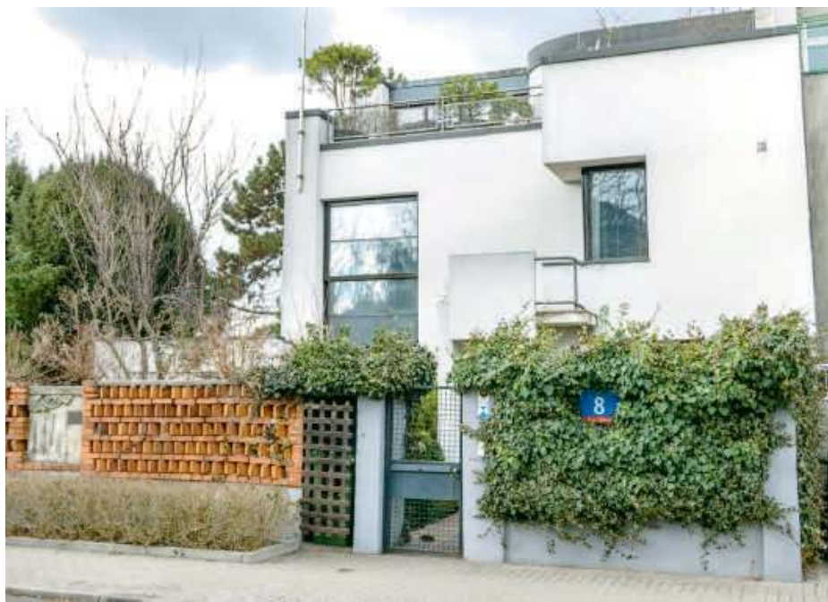
Na początku XX w. przechodniów szokowała bryła modernistycznej willi architektów Brukskich.
