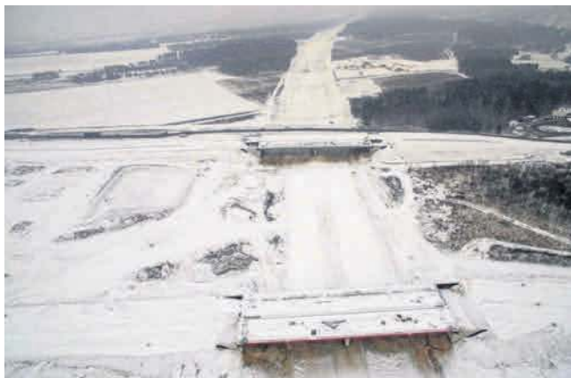
Tempo zaawansowania prac jest różne na poszczególnych odcinkach. Najgorzej wypada fragment Rzęsawa - Blachownia
