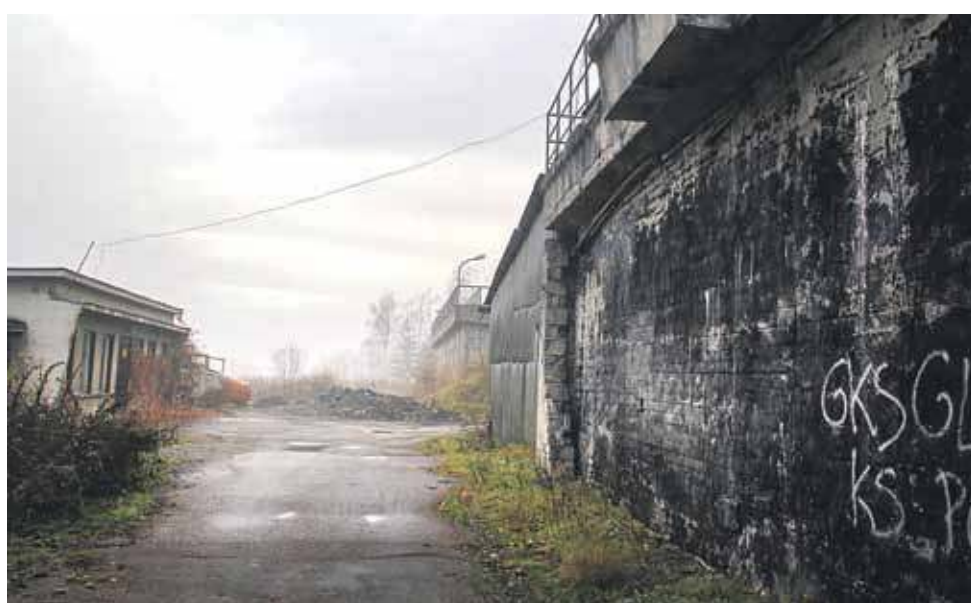
Zdegradowany teren starej oczyszczalni ścieków.
