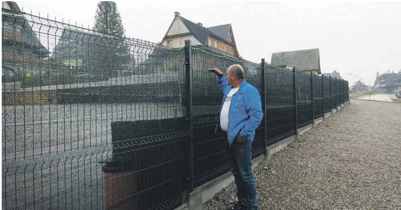
Jan Gąsienica pokazuje jak wysoka jest ściana "podziemnego" garażu, który ciągnie się wzdłuż jego działki w Małym Cichem.
