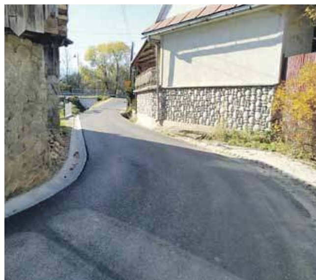
Ulica Budzowa po generalnym remoncie.
