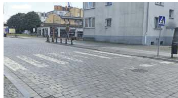
Już niedługo to przejście dla pieszych na ul. T. Kościuszki przejdzie gruntowny remont
