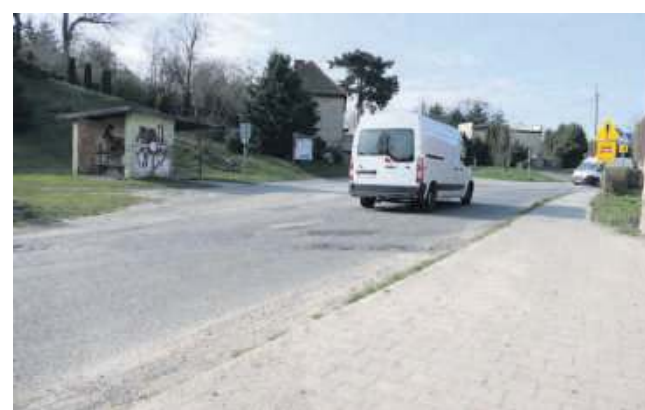
Gmina Strzelin przekaże 480 tys. zł na remont drogi powiatowej w Nieszkowicach
