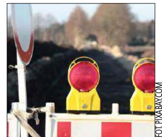
Na ul. Żurawiej będą prowadzone prace w obrębie jezdni i chodników, w związku z tym, na przedłużeniu ul. Artyleryjskiej ulica będzie nieprzejezdna
