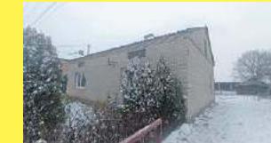
Dom do remontu w Kornie, 604 494 489
