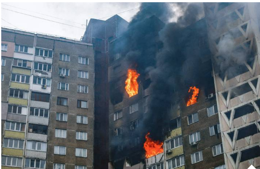
W wyniku rosyjskiego ostrzału zniszczeniu uległ 18-piętrowy blok w Kijowie | fot. VALENTYN OGIRENKO/Reuters/Forum
