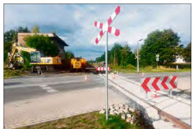
Dzięki wykonanym robotom poprawił się stan infrastruktury kolejowej oraz nawierzchni przejazdu, co wpłynie na komfort i bezpieczeństwo kierowców.
