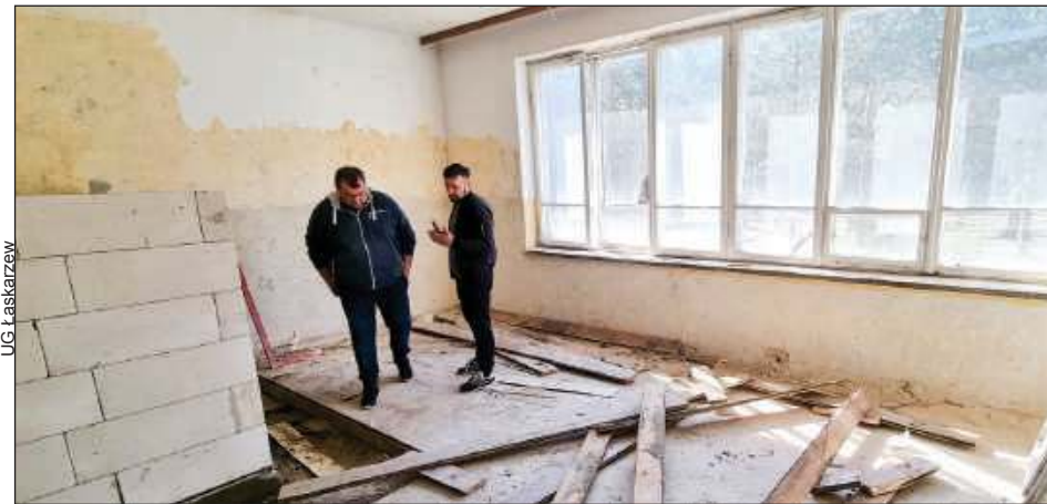
W kwietniu rozpoczęła się przebudowa budynku po byłej szkole, celem przystosowania go na potrzeby klubu. Na zdjęciu Marcin Wojda - inspektor z UG Łaskarzew i radny Maciej Wróbel
