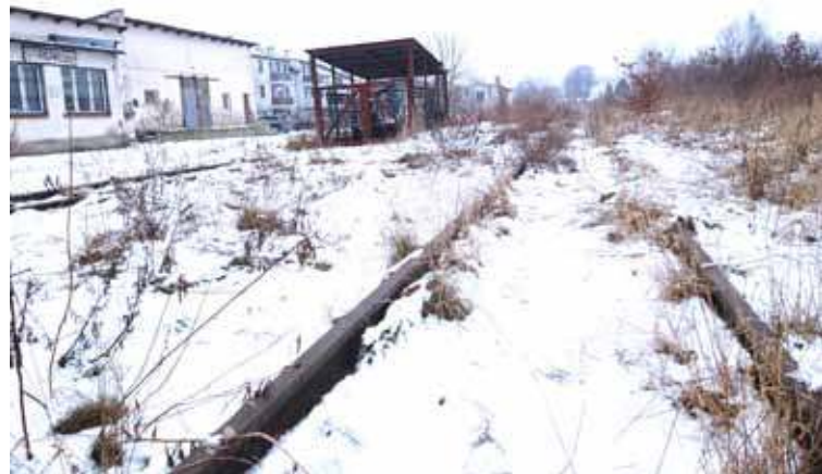
A tak jest obecnie. Stowarzyszenie Stargardzka Kolej Dojazdowa chce, by na stację wróciło życie - czyli dawny ruch kolejki wąskotorowej
