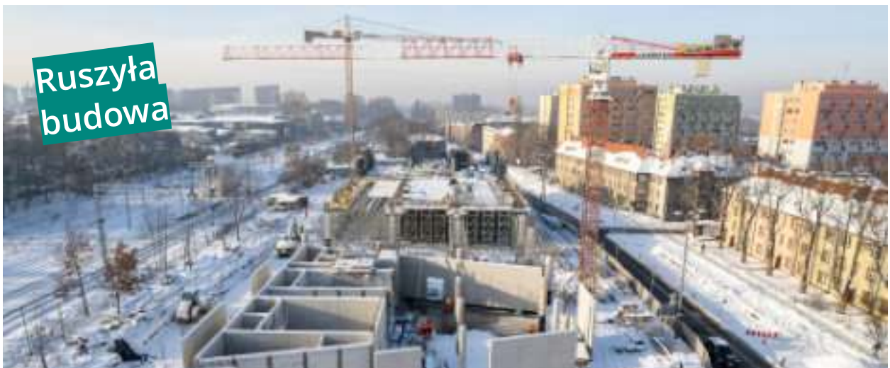
Ruszyła budowa centrum przesiadkowego przy ul. Goethego
