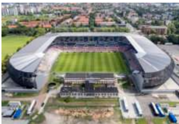
► Dokończenie budowy Areny Zabrze Fot. UM Zabrze
