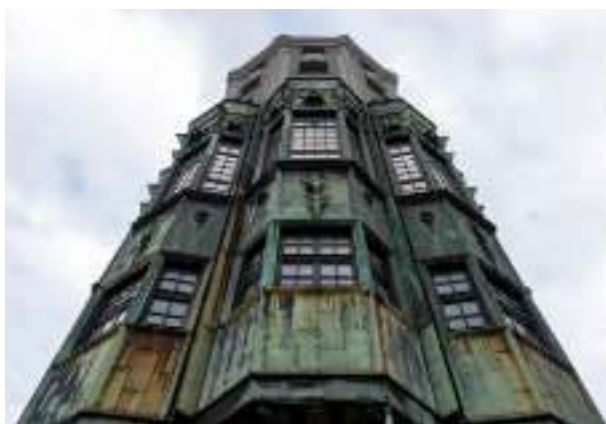
► Rewitalizacja dawnego hotelu Admiralspalast Fot. UM Zabrze
