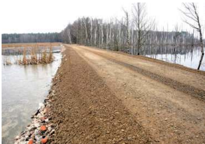
Drogowcy utwardzą nasyp siatką i kruszywem oraz wyleją dwie warstwy asfaltu
