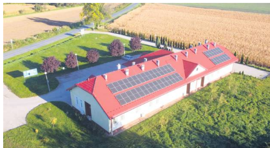
Panele fotowoltaiczne o mocy 20 kW zamontowano na dachu Ośrodka Zdrowia w Prusach. Fot. T. Gracz
