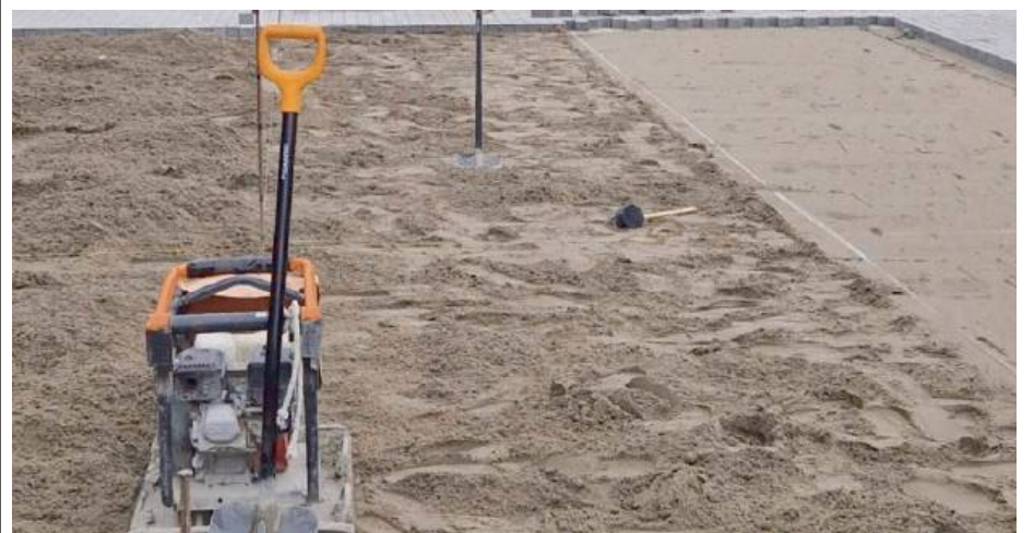
Prace remontowe trwają w kilku miejscach
