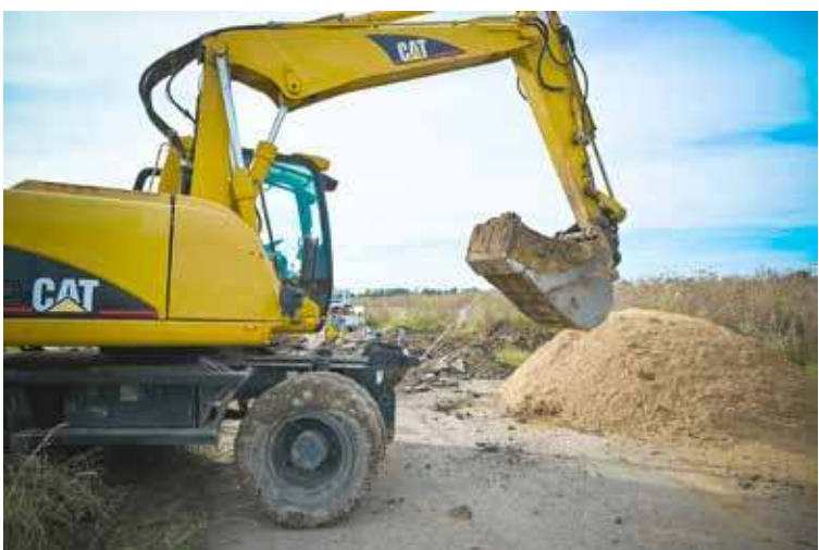
Wzdłuż przebudowanego fragmentu ul. Niklowej będzie m.in. ciąg pieszo-rowerowy. Całość uzupełni odpowiednie oświetlenie i kanalizacja
