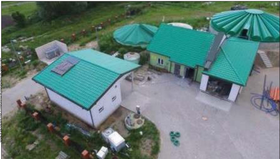
Rozbudowę oczyszczalni zajmie się firma Meliorant z Garwolina. Gmina przeznaczy na to zadanie ponad milion złotych
