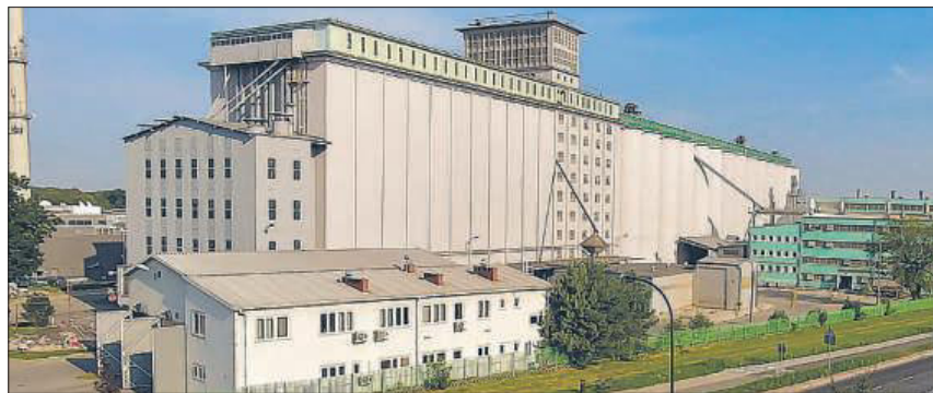
Główny cel, to modernizacja młyna i zwiększenie jego wydajności do 200 ton na dobę.
