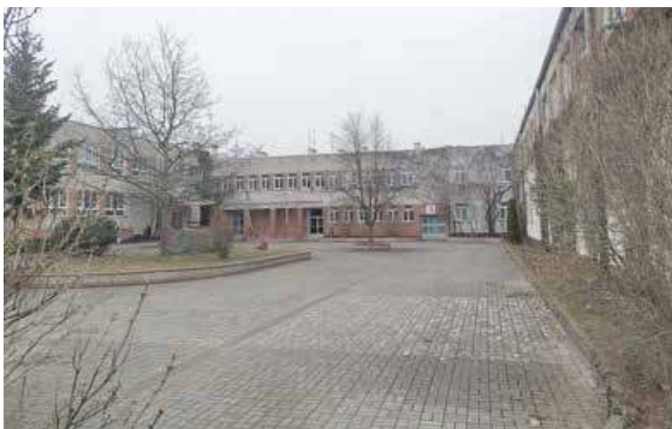
Piwnice szkoły przy ul. Bohaterów Warszawy według definicji nie można uznać za prawdziwy schron
