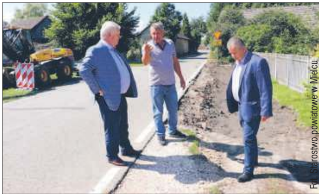
Przy drodze powstanie również chodnik.
