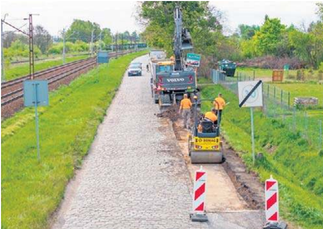
Na odcinku od ulicy Ziemniaczanej do granicy miasta, na długości 700 metrów, utwardzane jest pobocze
