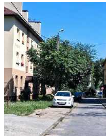
Mieszkańcy w końcu doczekają się obiecywanych remontów.
