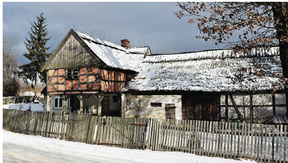
Łęcze. Dom powstały w 1846 r. z podcieniem w konstrukcji szkieletowej, wypełniony dekoracyjnie opracowanym szachulcem, usytuowany kalenicowo do drogi
