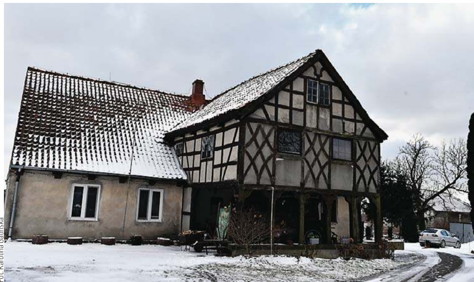
Próchnik. Dom podcieniowy, wybudowany w 1938 r.
