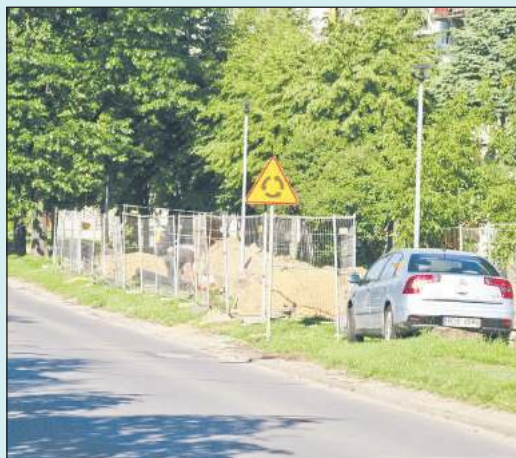
Trwa przebudowa chodnika przy ul. Tysiąclecia.
