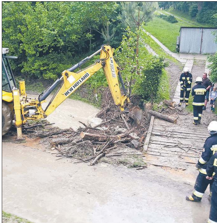
Do usunięcia gałęzi i pniaków konieczna była koparka. fot. OSP Podgrodzie
